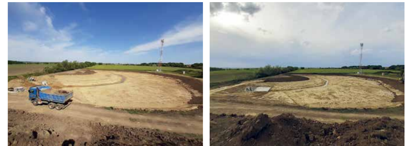
39 – Pond construction in Rákócziújfalu. (Photos: József Varga, Rákócziújfalu)
